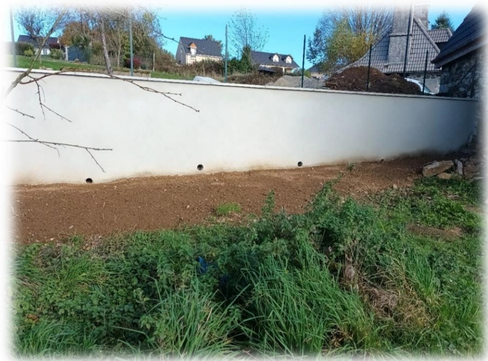
Vue du côté de l'enclos de l'ancien presbytère
