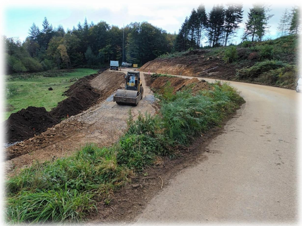
RD 20 en cours de chantier
